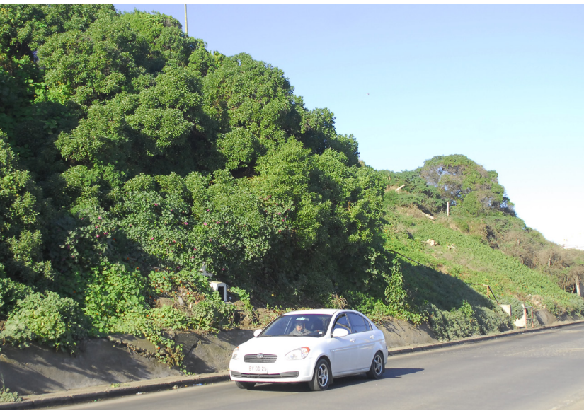
Imagen 65_ Talud cerro Panul, Galería Fotográfica Personal
