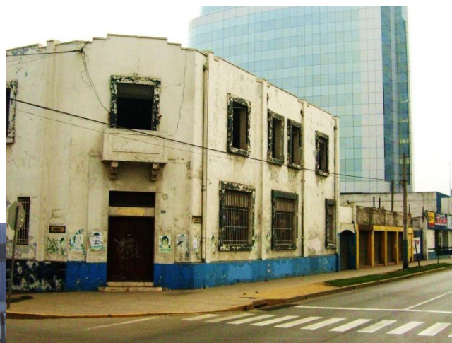
Imagen 40_ Edificio Abandonados, Informe San Antonio; Fernanda Contreras
