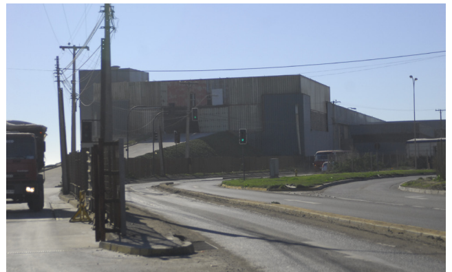
Imagen 96_ Edificio terreno, Galería personal
