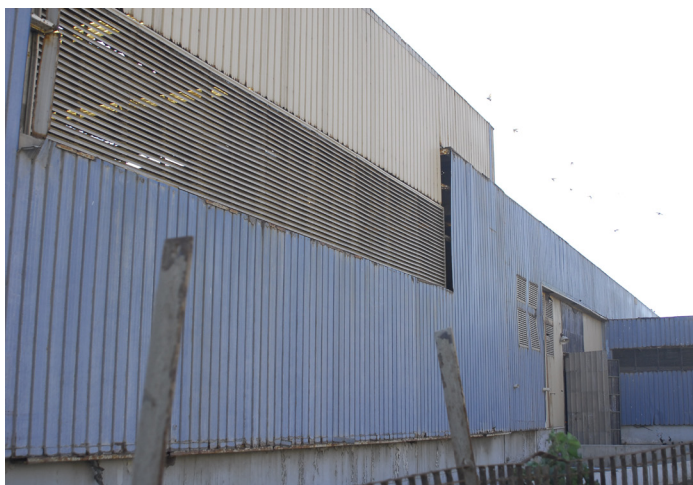
Imagen 39_ Bodegas en desuso, Galería personal
