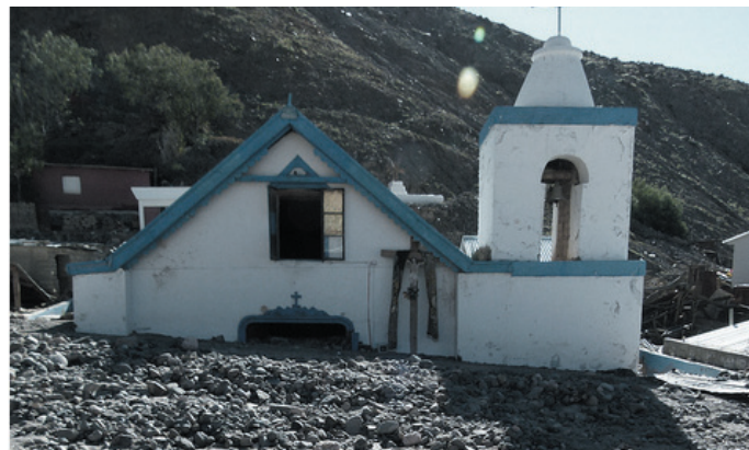
Fig.2.5: Iglesia de Chapiquilta antes y después del aluvión Fuente: autor e internet.
