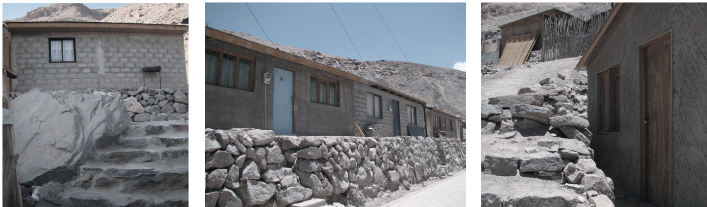
Fig.2.16: Viviendas nuevas en Camiña y su adaptación a la pendiente Fuente: Autor.
