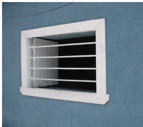
Fig.2.20: Vanos de casa Camiñana, Madera de cactus candelabro y piedra. Fuente: Autor
