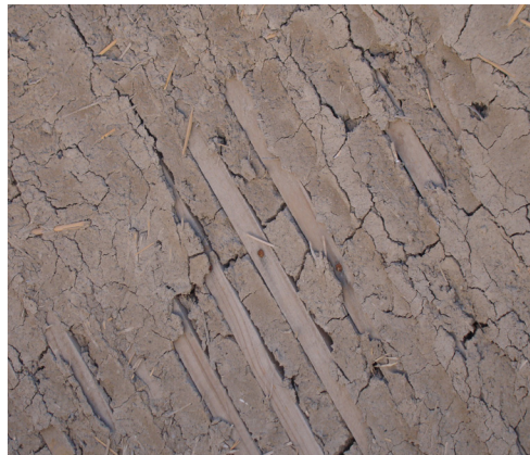
Fig.2.19: Sistema de quincha, cubierta con torta de paja con barro y caña. Fuente: Autor
