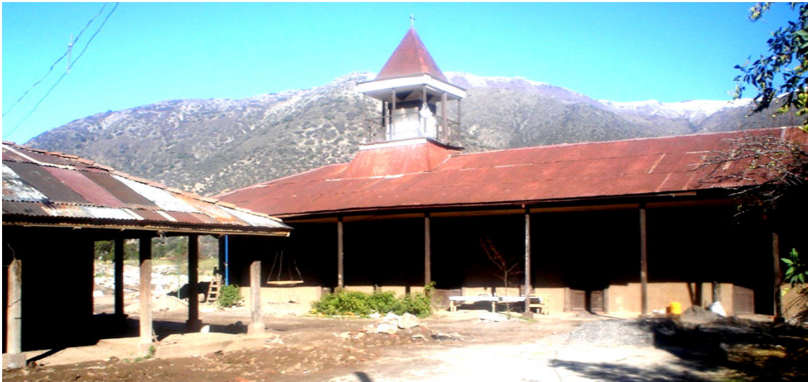
Fig.2.2.5.1.Parroquia (Inmueble patrimonial). En deterioro. Fuente: Archivo Personal
