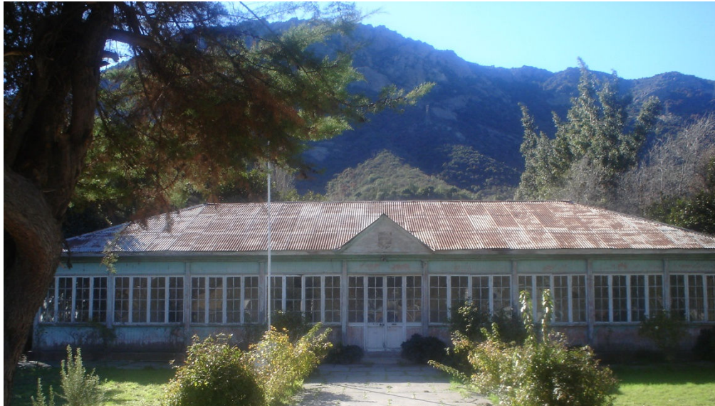
Fig. 2.2.5.3. Edificio de Aduana.1840. Inmueble patrimonial. Núcleo central de estructura en madera con adobillo, rodeado de galerías. De fondo cerro Pitihues (1.666 m.s.n.m.) Foto: Archivo Personal
