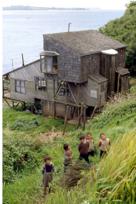
Fig.1 Casa del Pescador. Arquitecto Jorge Lobos.
