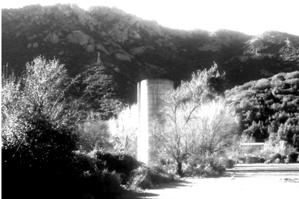
Fig.2.2.5.2.Silo de ferrocemento. Fuente: Archivo Personal
