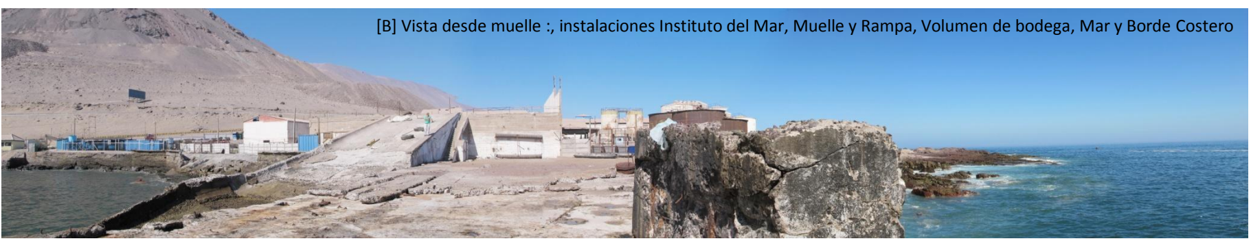
[C] Vista desde la explanada de descuartización : Muelle y rampa, muro de protección costero, instalaciones Instituto del Mar
