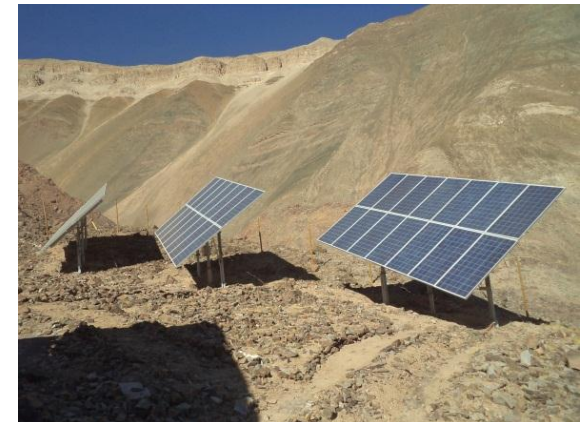
Paneles solares que dotan de energía eléctrica a la localidad
