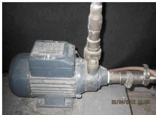
Fig. 3.9: Fotografía bomba conducción agua caliente.
