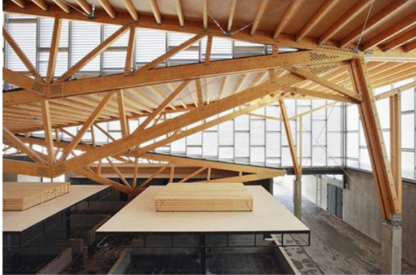
Mercado Inca, Mallorca, España. Arqtos.: Charmaine Lay & Carles Muro
