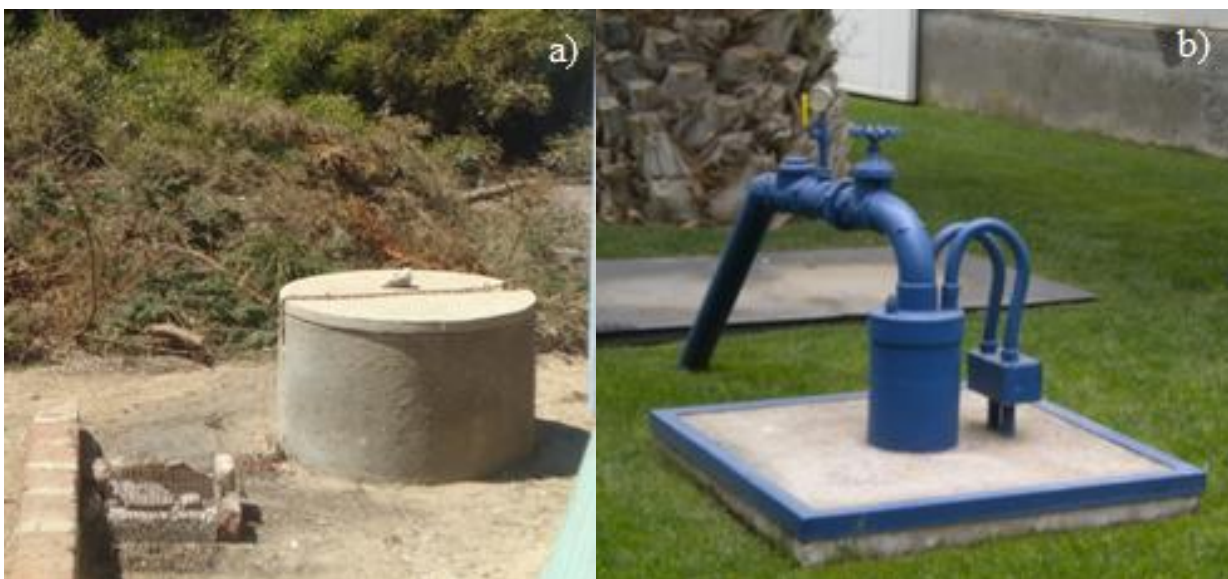
Figura 2.35: a) Pozo sin uso de extracción de agua (imagen propia de propiedad en la comuna del Tabo, V región, Chile. b) Pozo profundo (imagen propia de instalación en edificio de Compañía Chilena de Perforaciones Ltda.. Pudahuel, Región Metropolitana, Chile).
