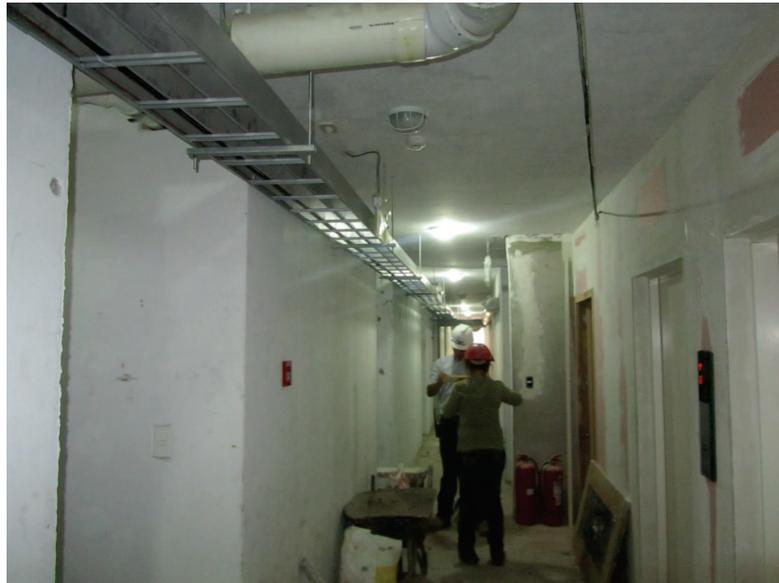
Figura 5.27: Pasillo Subterráneo canal de cables
