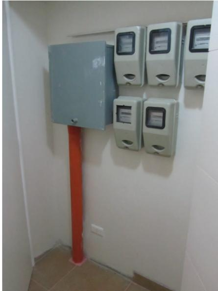
Figura 5.14: Medidores piso 11 – Punto de corriente
