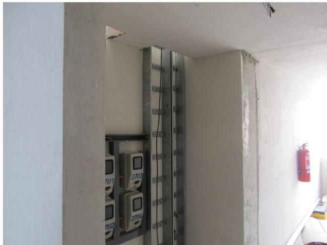
Figura 5.24: Shaft eléctrico sin puertas vista
