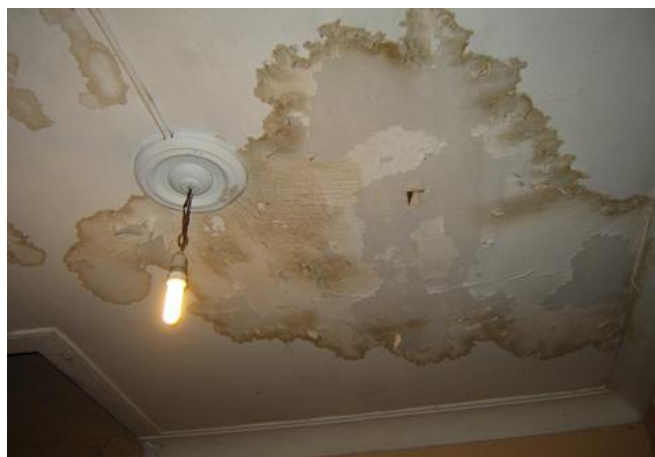
Vista interior de la casa. Manchas de humedad en el techo.
