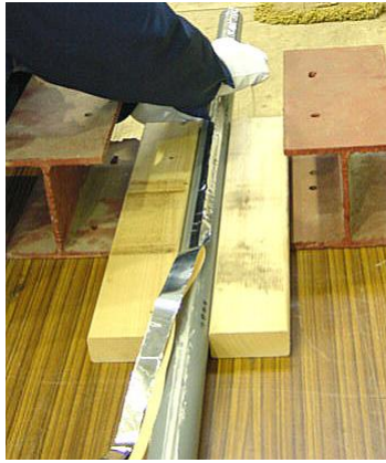
Figura 2-7: Pegado de la fibra óptica
