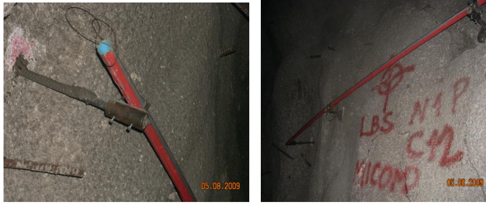
Figura 2-8: Fotos de sensores TS en la mina (MICOMO).
