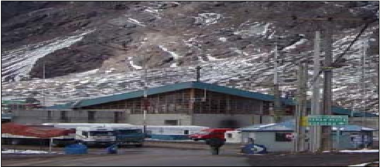
Figura 24: Vista Externa Complejo Actual.
