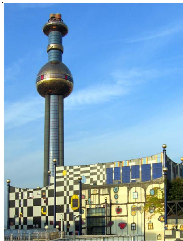
Figura 13. Planta de incineración de Spittelau ubicada en el centro de Vienna, es una de varias plantas que proveen electricidad y calefacción domiciliaria en la capital de Austria.
