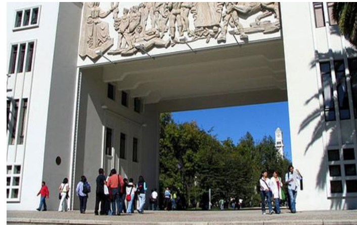
PORTAL DE ACCESO DE LA UNIVERSIDAD DE CONCEPCIÓN
