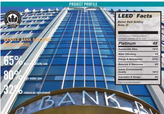
Edificio del Banner Bank. Boise, Idaho, EE.UU. FUENTE: U.S. Green Building Council www.usgbc.org
