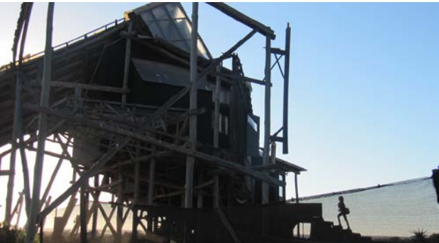
Hospedería de la Entrada. 1983. Ciudad Abierta, Ritoque, V Región, Chile. FUENTE: Elaboración Propia.
