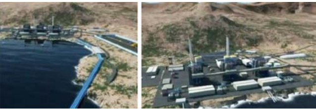
Termoeléctrica Barrancones. FUENTE: www.plataformaurbana.cl
