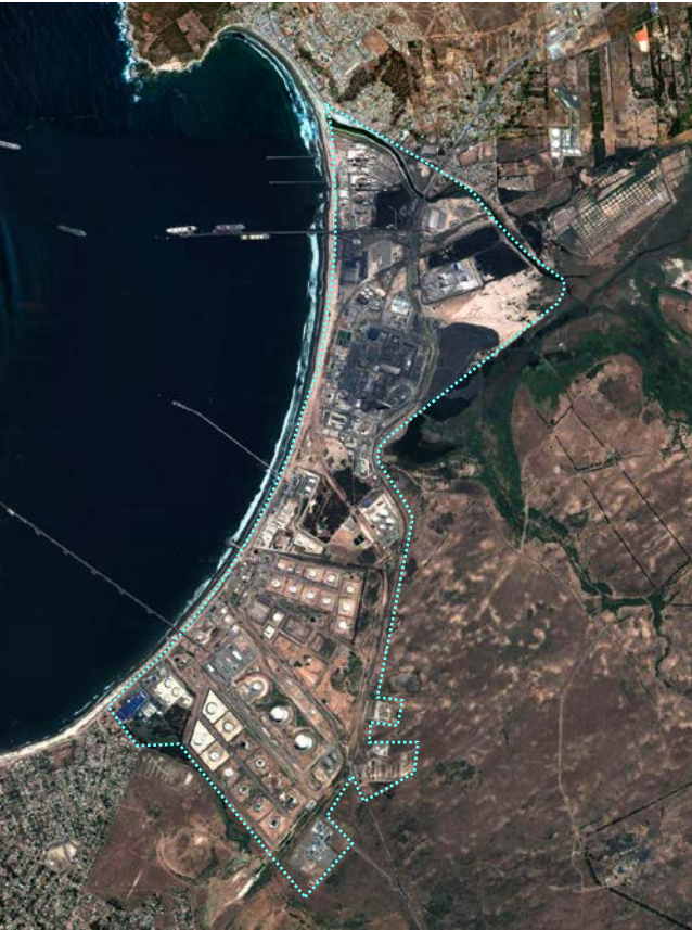
Zona Industrial de la Bahía de Quintero FUENTE: Google Maps
