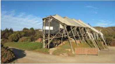
1. Hospedería de la Entrada, 1983
