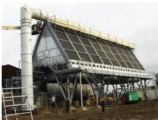
Figura 2.12. Condensador enfriado por aire.
