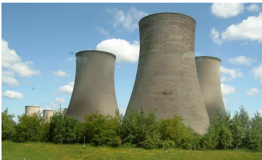
Figura 2.11. Torres de enfriamiento evaporativas.
