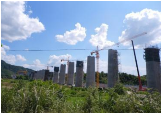
Construcción de una autopista en China – Julio 2010
