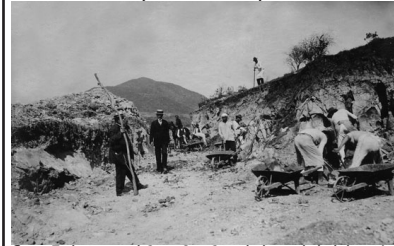
fig. 6 Trabajos en el Cerro San Cristobal para la habilitación de caminos. fte.: www.pms.cl
