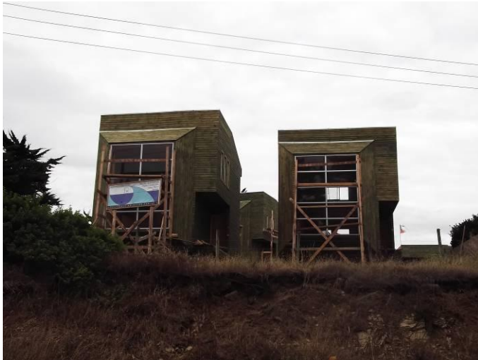
Construcción 4 → Muros de madera y techo oculto
