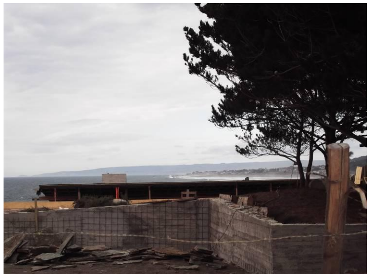
Construcción 5 → Muros de madera y techo oculto.
