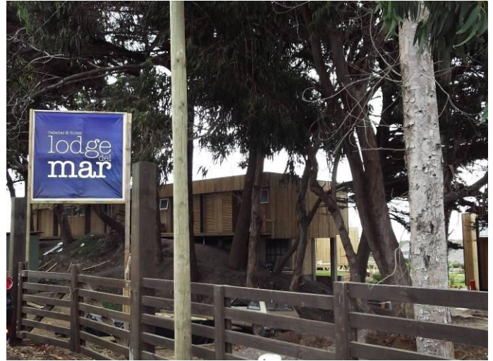
Construcción 3 → Muros de madera y techo oculto.
