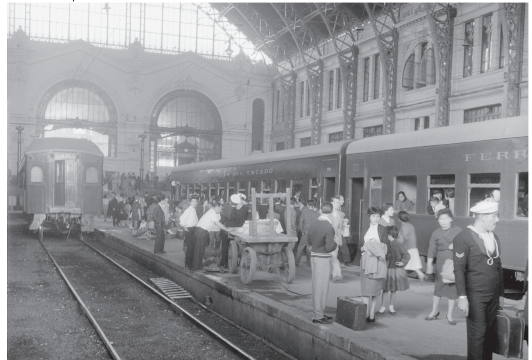
Memoria Visual de una Estación Ferroviaria
