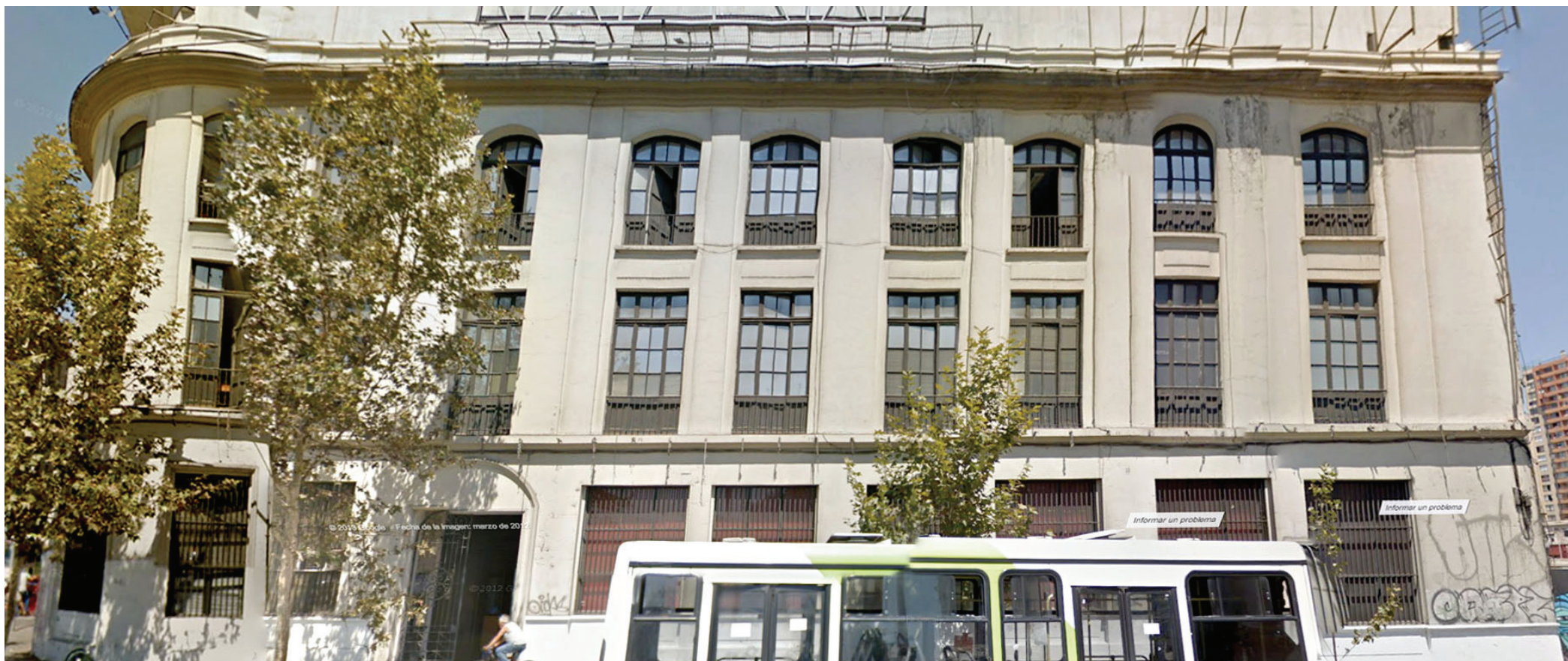
Fachada norte del deteriorado Ex Hotel Bristol Elaboración propia
