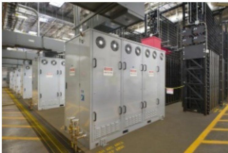
Figura 2.13 BESS de plomo ácido en Kahuku, Hawaii [21].
