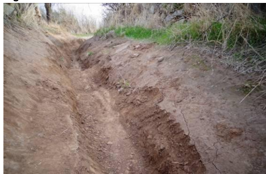
Fig. 7. Proceso erosivo escurrimiento concentrado.
