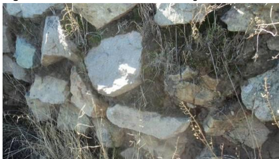
Fig. 77. Detalle Muro interior. Agosto, año 2013.
