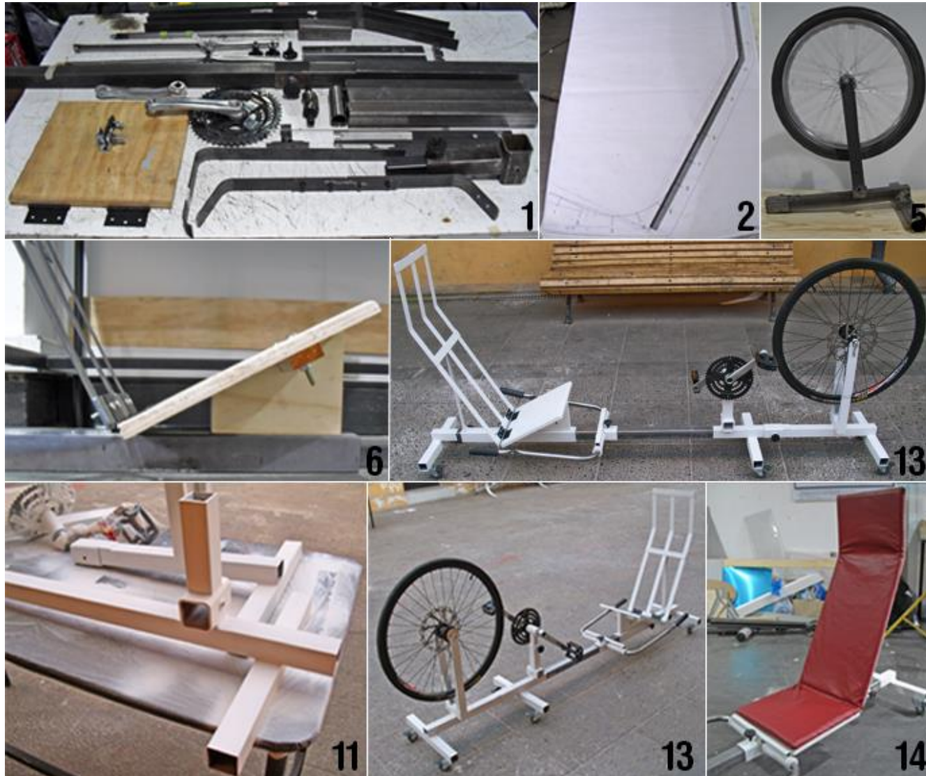
Imagen: Construcción JIG 3. Elaboración propia.
