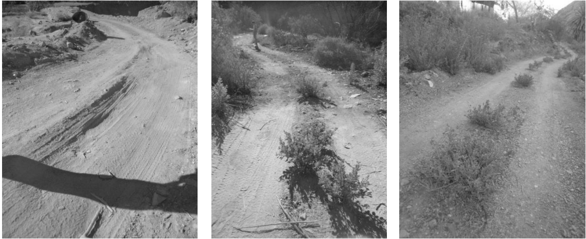
Figura 4-7: Estados camino ruta vertedero.
