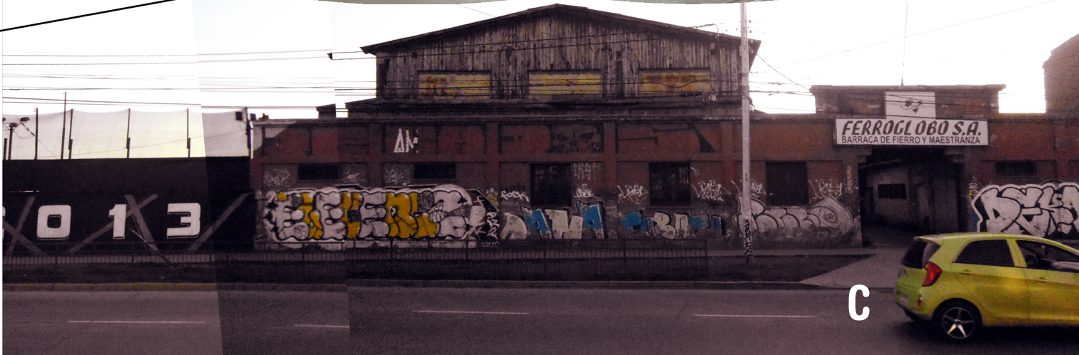
FIG. 56 Panorámicas de Santa Rosa esquina Placer Elaboración propia y a base de Google Street View, 2012
