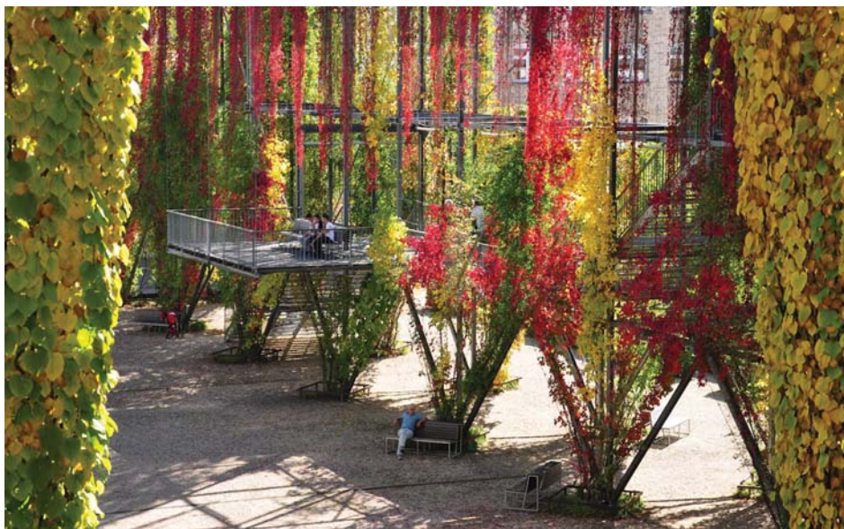
Imagen 45 Sistema Jacobs con trepadoras Fuente, "El detalle en el paisajismo", 2008
