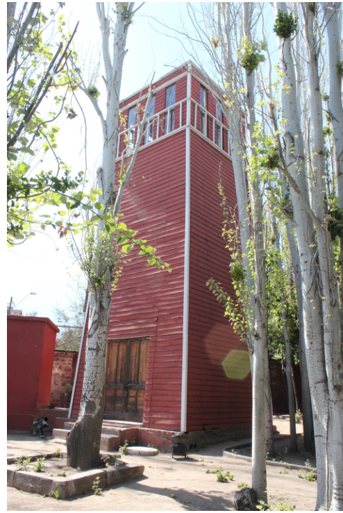
Torre de agua (reconstrucción)
