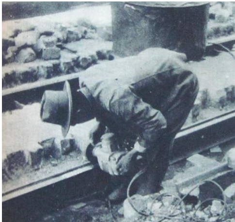
Img. 05. (E05) Trabajos sobre Av. Providencia Zigzag , N° 1392, 1931
