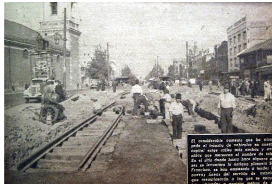
Img. 14. (C14) Instalación de rieles. Zigzag . n° 1880, 1941
