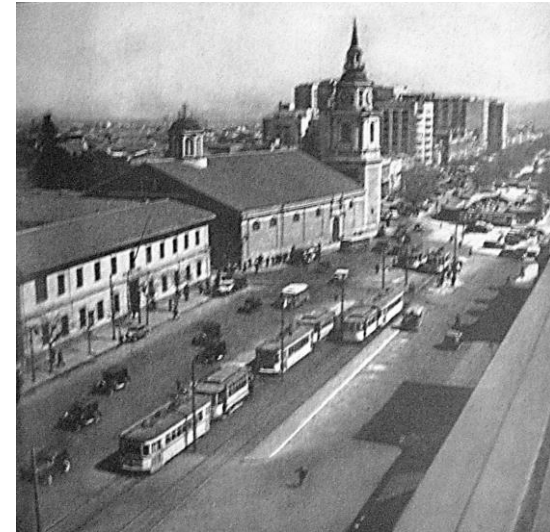
Img. 15. (C15) Vía despejada. Zigzag . n° 1905, 1941
