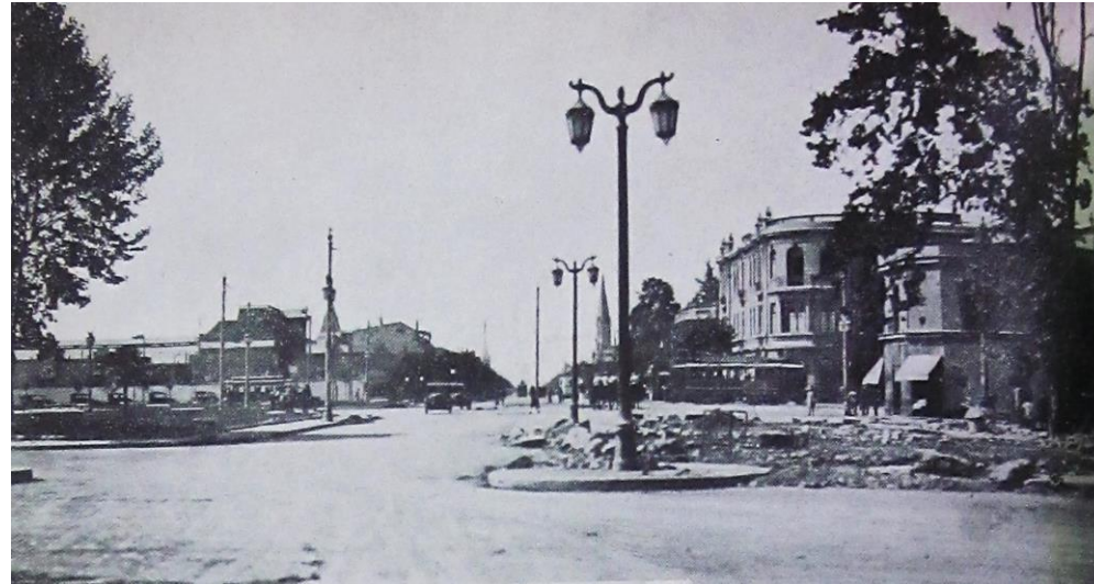
Img. 02. (D02) Pavimentación en V. Mackenna. Zigzag . n° 1250, 1929
