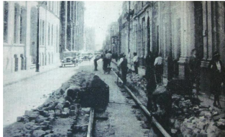
Img. 06. (E06) Reparaciones sobre línea de tranvías Zigzag , N° 1392, 1931
