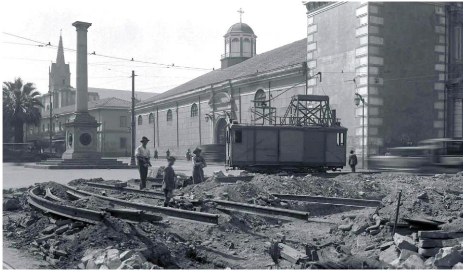
Img. 04. (C04) Trabajos en San Francisco. Archivo Chiletra , 1928
