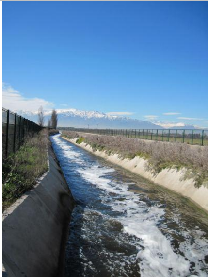
Fig.30.-Canal de vertido de aguas al río Mapocho, ya saneadas en La Farfana en lo referido a las aguas servidas. 2010.
