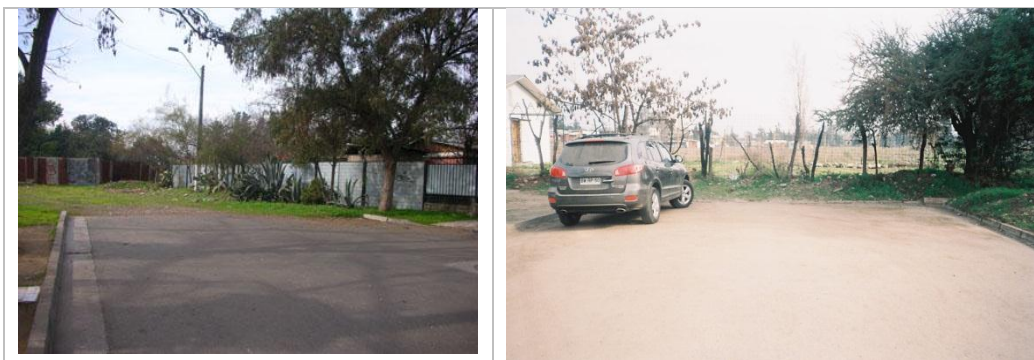
Figs. 12 y 13.- Extremos actuales del tramo mayor construido de Costanera de Talagante, en los puntos de interrupción de la obra al norte y al sur, (primer tramo referido), 2009.
