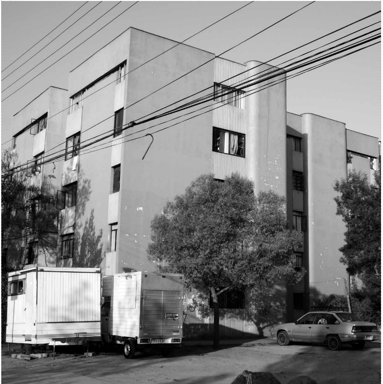
Uno de los «blocks» actualmente habitados de la Villa San Luis. En términos de su arquitectura el conjunto enfatiza su carácter masivo, para ellos recurre a una tipología de bloque de media altura (5 pisos) y gran longitud. Foto de Claudio Pulgar, 2008.
