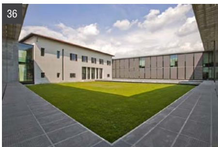
FIG 34-36 Mondadori - Ex-Cascina di Tregarezzo / Werner Tscholl, Architekt / Segrate _ Italy _ 2007
