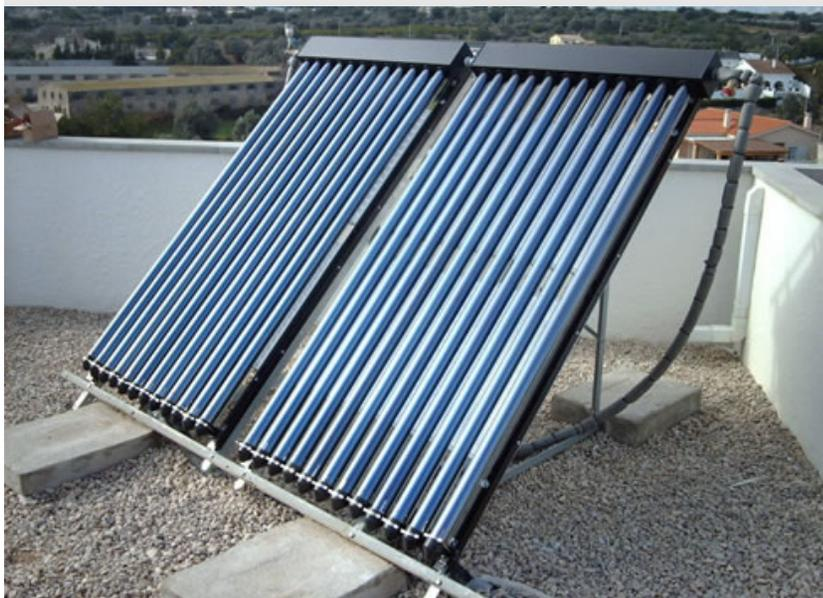
Figura N°21. Paneles Solares de Tubos al Vacío. Fuente: [www.crisenergiasolar.com](http://www.crisenergiasolar.com).
