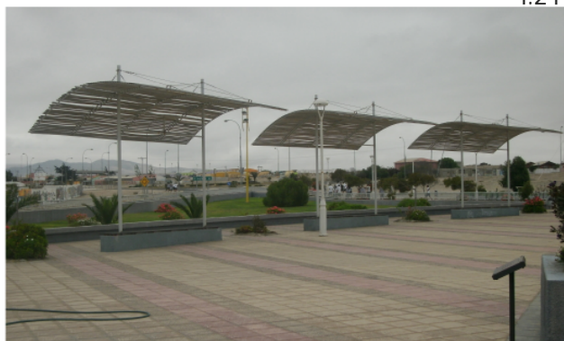
SOMBREADERO EN CALDERA
