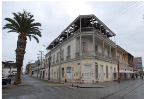
f.30 Calle Baquedano Iquique http://www.panoramio.com/photo/38650041
