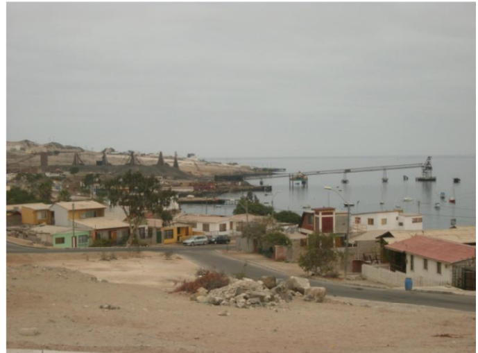
f.7 Puerto mecanizado de Caldera
