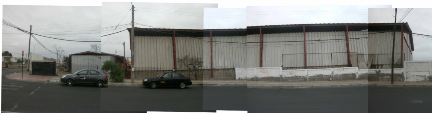
NORDESTE f.48 vista desde Ossa Cerda.
