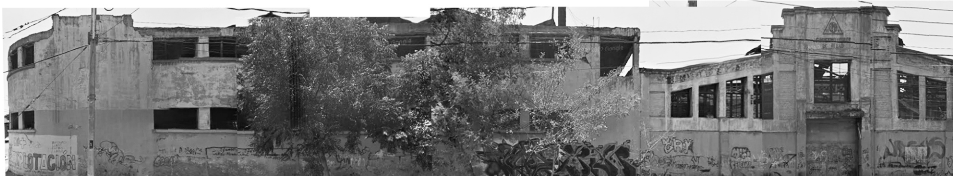
Levantamiento fotografico exterior Fachada poniente / Calle Herrera ex fundición Metalco
