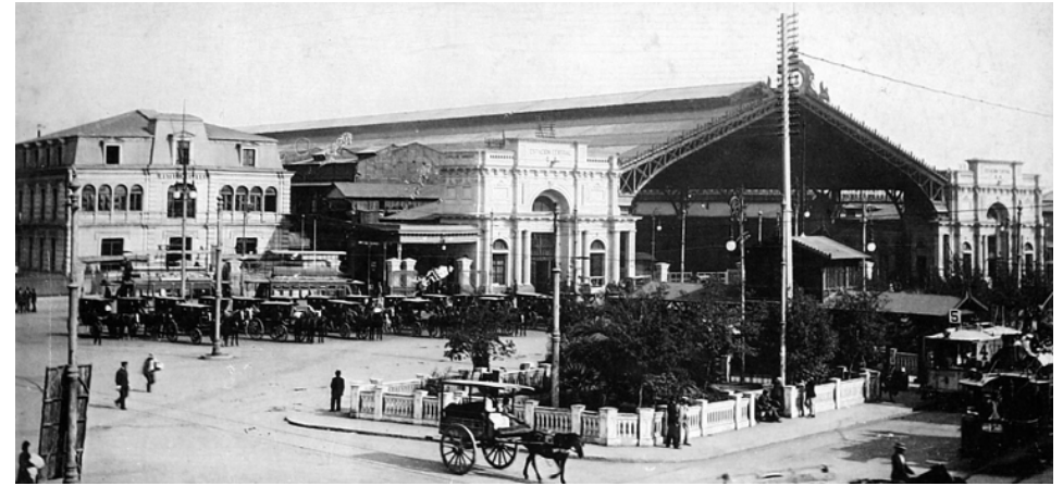
Barrio Chuchunco / Estación Central Plaza Argentina 1900
