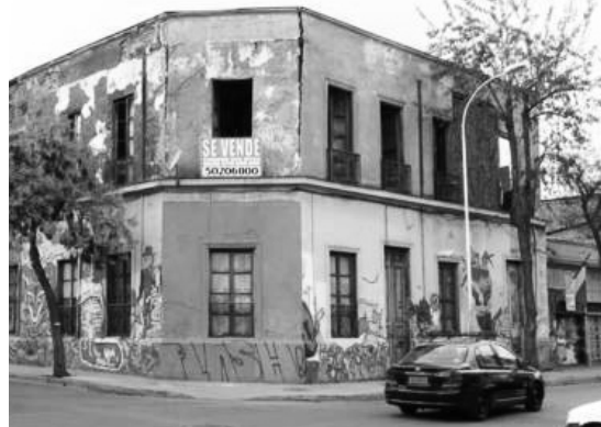
Edificio esquina de la Plaza Yungay observación de deterioro y abandono de los inmuebles
