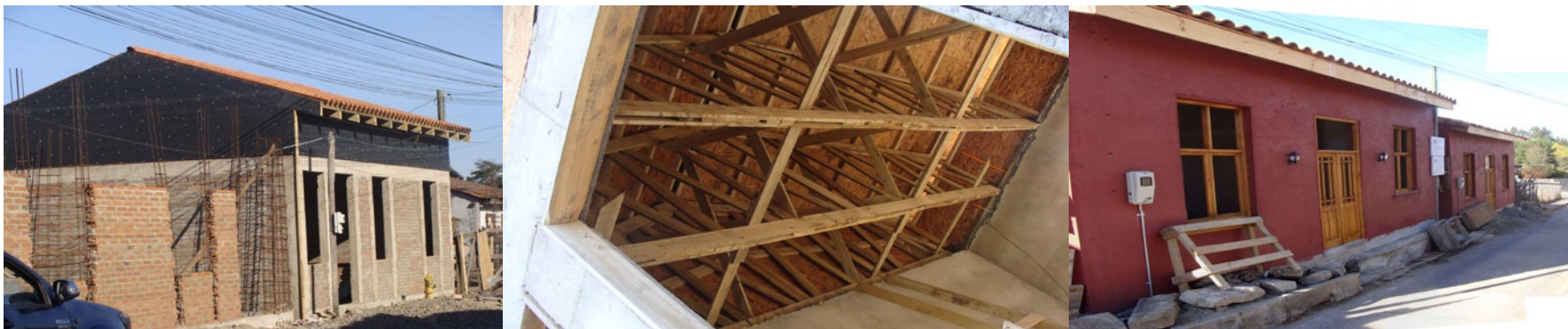
De izquierda a derecha: inmueble nuevo construido en albañilería confinada, acercamiento de la nueva estructura de techumbre y otro inmueble nuevo con terminaciones en fachada. Fuente: Archivo Fotográfico del Autor.
