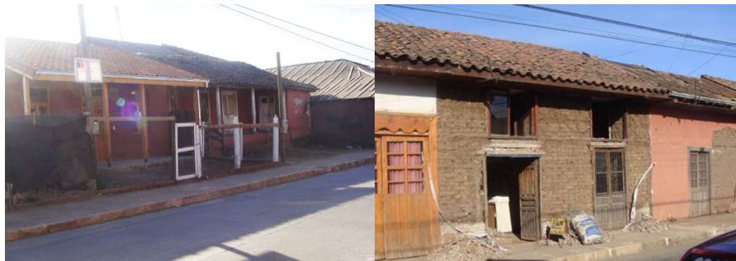
Elementos nuevos y reparaciones de estructuras preexistentes en adobe. Fuente: Archivo fotográfico del Autor.
