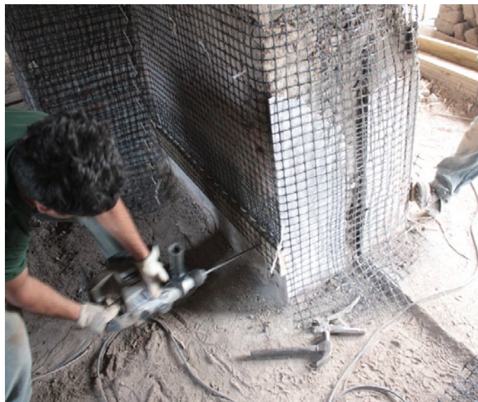
Reparación de una estructura de adobe mediante la incorporación de geomalla. Fuente: http://www.plataformaarquitectura.cl/
