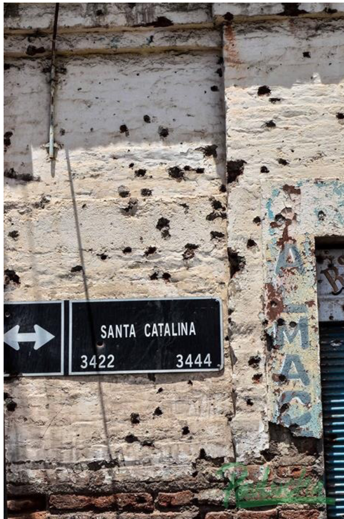
Muro baleado debido a enfrentamientos entre carteles de narcotráfico en el pasaje Santa Catalina, Legua Emergencia. Fotografía tomada el 13 de agosto de 2014.
