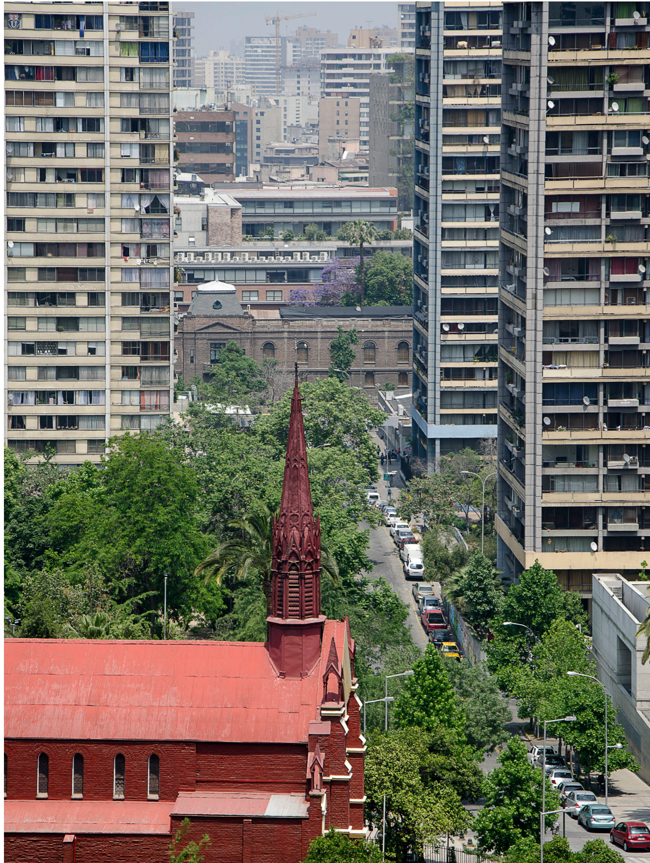
Arriba: Vista a iglesia San Francisco de Borja y torres 2, 3 y 4, Remodelación san Borja (2014).
