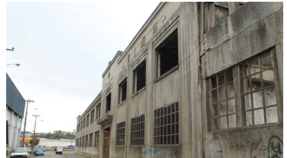
Fig.21 Fachada Fábrica FIAP Elaboración Propia
