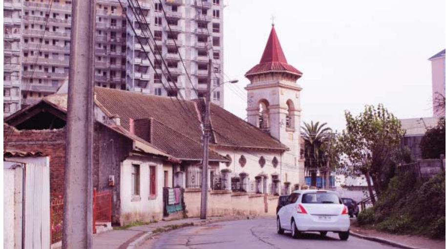
Fig.5 Iglesia Cristo Rey contrastada con edificio de inmobiliaria Elaboración Propia
