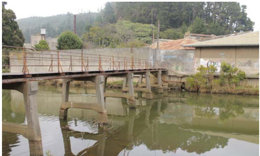
Fig.6 Puente Peatonal en Estero Bellavista Elaboración Propia
