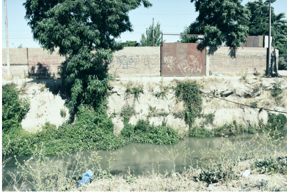
Vistas Canal Gallinas Blancas, Fotografías del Autor
