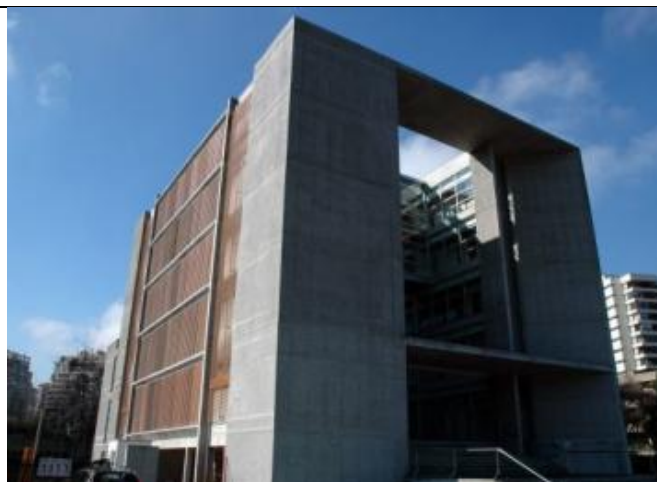
[Fig.77]: Edificio de la Organización Internacional del Trabajo
