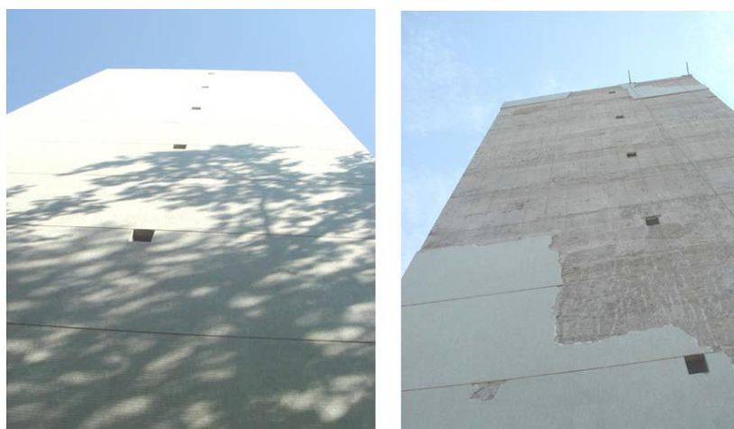
Costado edificio recién terminado
