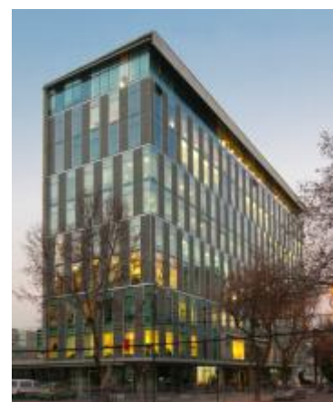
Costanera Cosas Providencia, Santiago año construcción 2008
