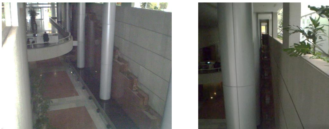
[Fig.45]: Acceso edificio Consorcio
