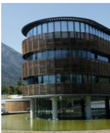
Transoceánica Business Park Avenida Santa María 5880 año construcción 2008
