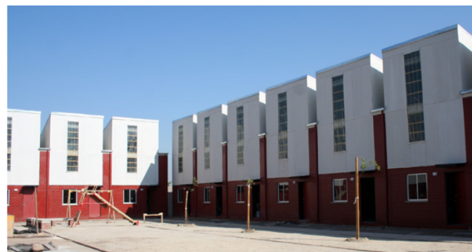
Elemental Rancagua Hormigón armado, ladrillo y madera
