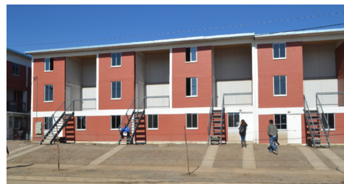
Elemental Rancagua Hormigón armado y ladrillo
