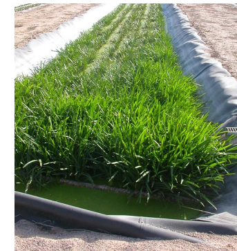
Filtro de depuración
