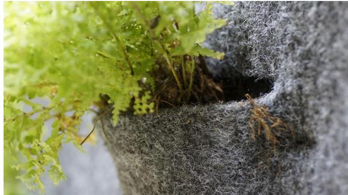
*Figura 5: Detalle del "Bolsillo" de un sistema tipo fieltro.*
