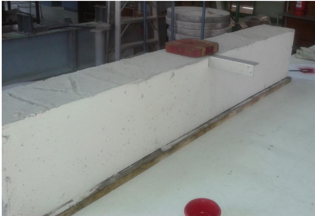
Figura 37. Superficie de viga pintada con cal
