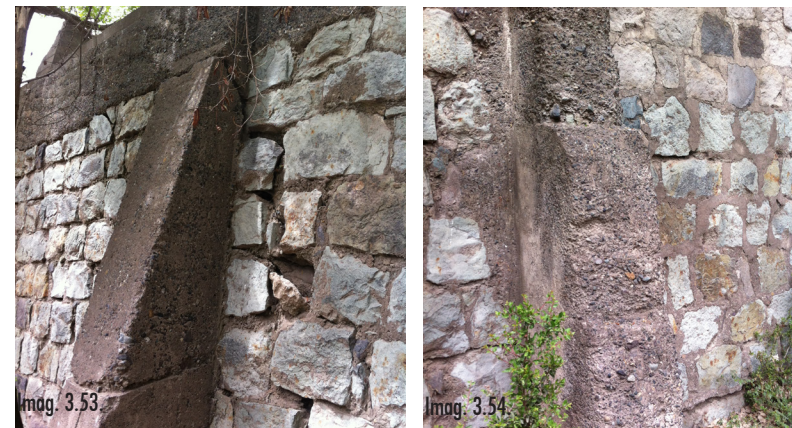
Fig. 3.18. Identificación en planta de las zonas dañadas. Fuente: Elaboración Propia Imag. 3.51. a Imag. 3.54. lesiones por erosión. Fuente: Archivo Personal
