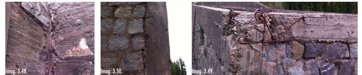
Fig. 3.17. Identificación en planta de las zonas dañadas. Fuente: Elaboración Propia Imag. 3.45. a Imag. 3.47. lesiones por oxidación Fuente: Archivo Personal Imag. 3.48. a Imag. 3.50. lesiones por Grietas Fuente: Archivo Personal
