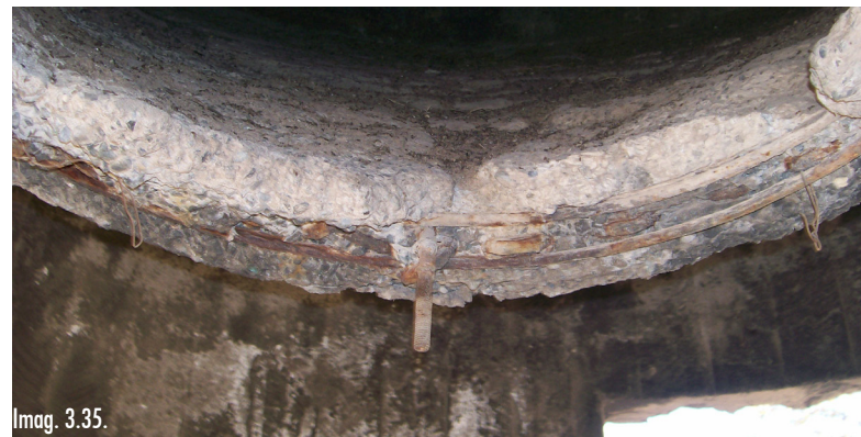
Imag. 3.32. y Imag. 3.33. lesiones por Daños antrópicos. Fuente: Archivo Personal Imag. 3.34. y Imag. 3.35. lesiones por oxidación. Fuente: Archivo Personal
