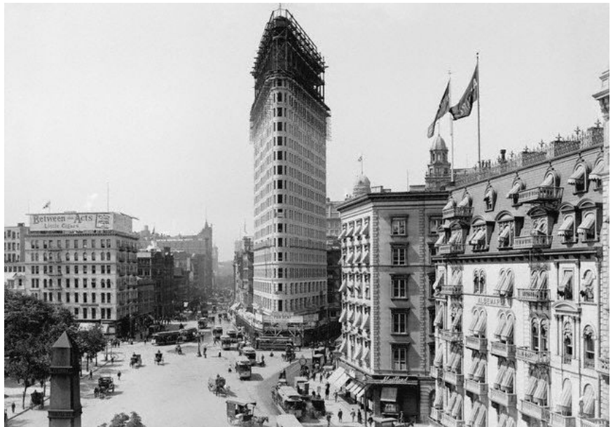
Fig. 0.3.2. Construcción del emblemático "Flatiron". Mostrando la construcción como representación de poder.
