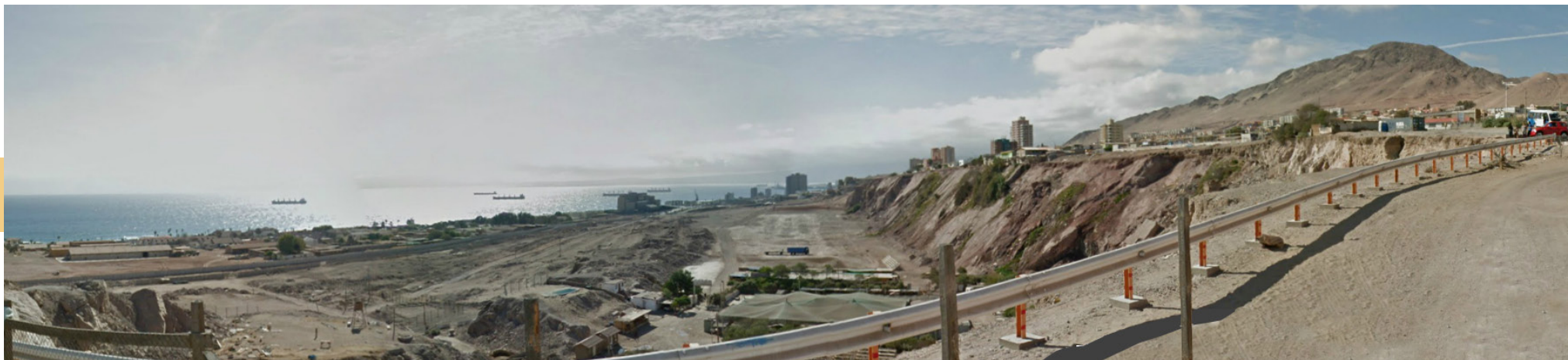
Imagen 45: Vista de la explanada, desde la calle Sta. Margarita (Coviefi) hacia el Norte. Fuente: Elaboración Propia en base a imágenes de Google Street View.
