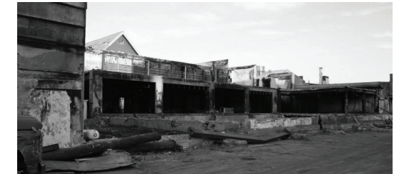
Figura 82 Terreno Galeria Nass Franlic 2014
