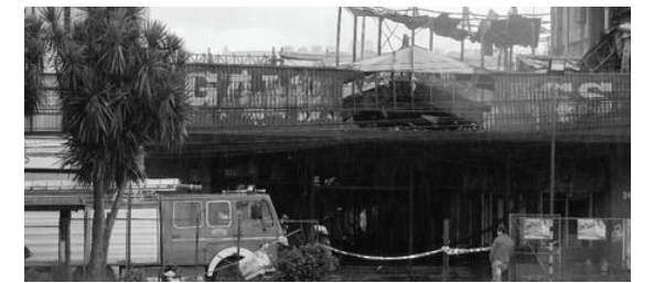
Figura 83 Galeria Nass tras el incendio desde calle Chacabuco Fuente: www.24horas.cl
