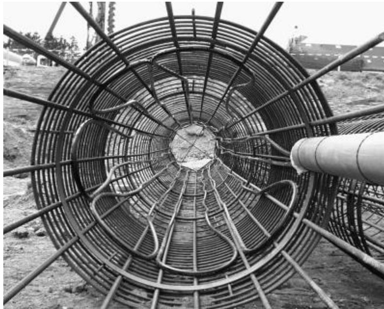
ILUSTRACIÓN 1.2: TUBOS ABSORBENTES FIJADOS A LOS REFUERZOS DE FIERRO. FUENTE: (1)
