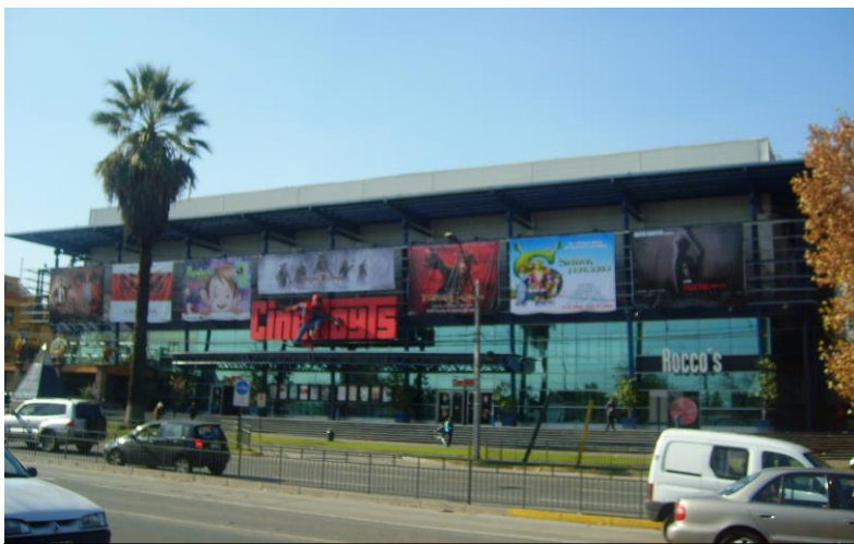
Vista exterior Cine Hoyts, de la Reina, ubicado en el Enclave Oriente del AMGS
